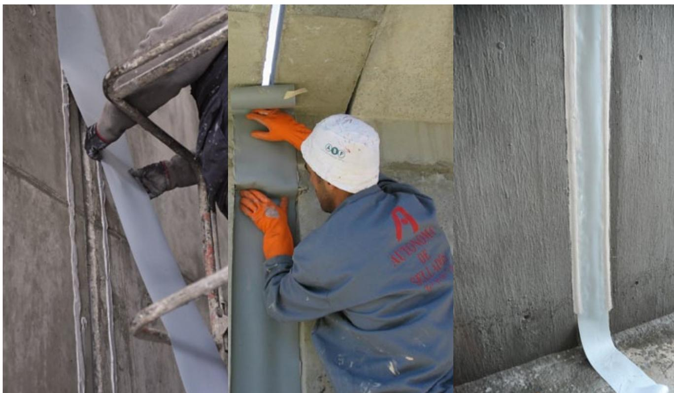
Secuencia de instalación de banda elástica MASTERFLEX 3000 en junta de dilatación.
