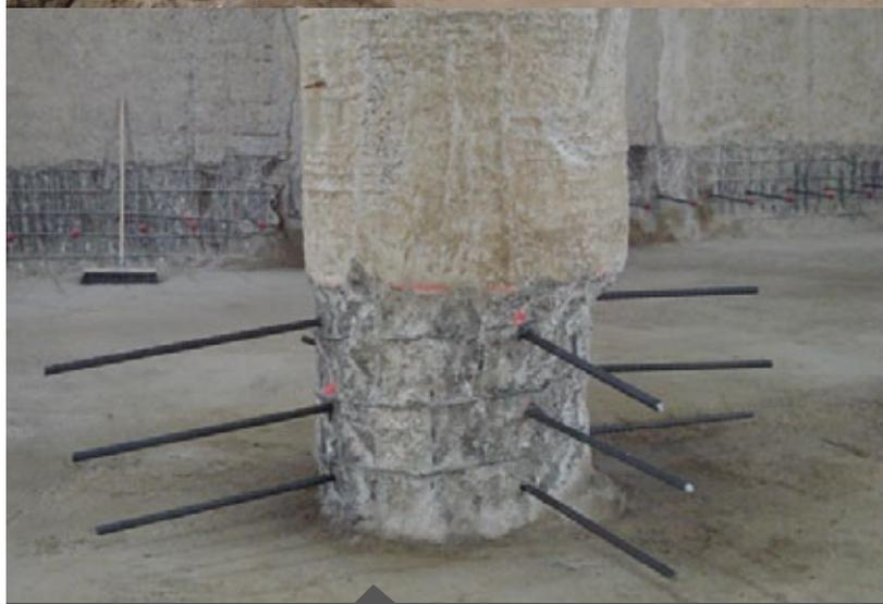
Anclajes con colocación de varillas de acero corrugado. Depósitos del Pardo en Madrid
