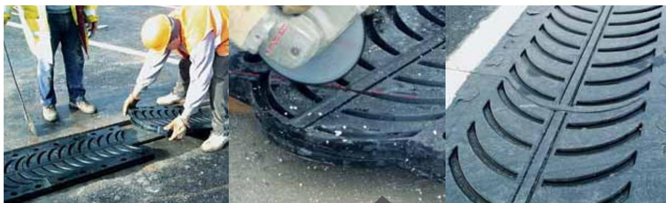
Secuencia de instalación de junta de Dilatación Monolítica
