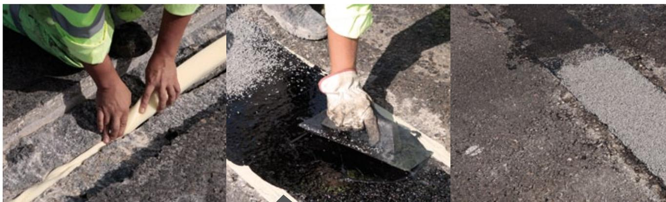
Secuencia de instalación de Junta Elástica
