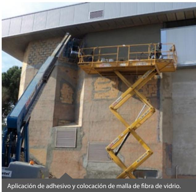
Aplicación de adhesivo y colocación de malla de fibra de vidrio.
