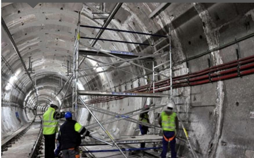
Trabajos de impermeabilización, reparación y tratamiento de juntas en túnel de línea de Metro de Madrid
