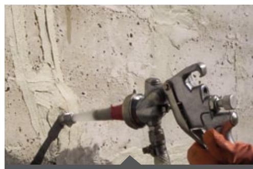
Inyección de resina en fisuras
